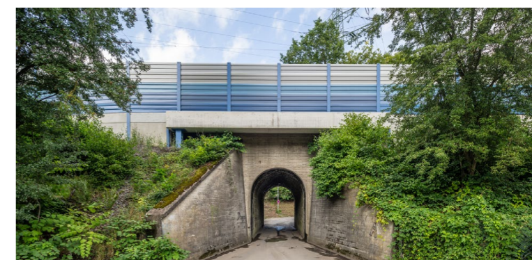
Beispiel für eine aktive Schallschutzmaßnahme: Schallschutzwand
